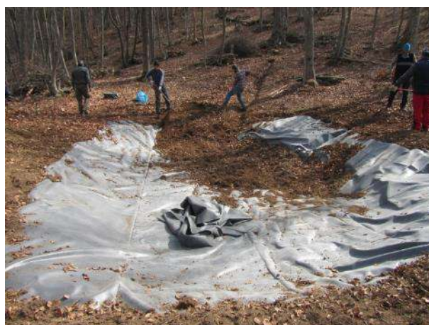
Fasi realizzative - trasporto dei materiali, scavo manuale, posa e naturalizzazione del fondo con posa di strato di terra.
