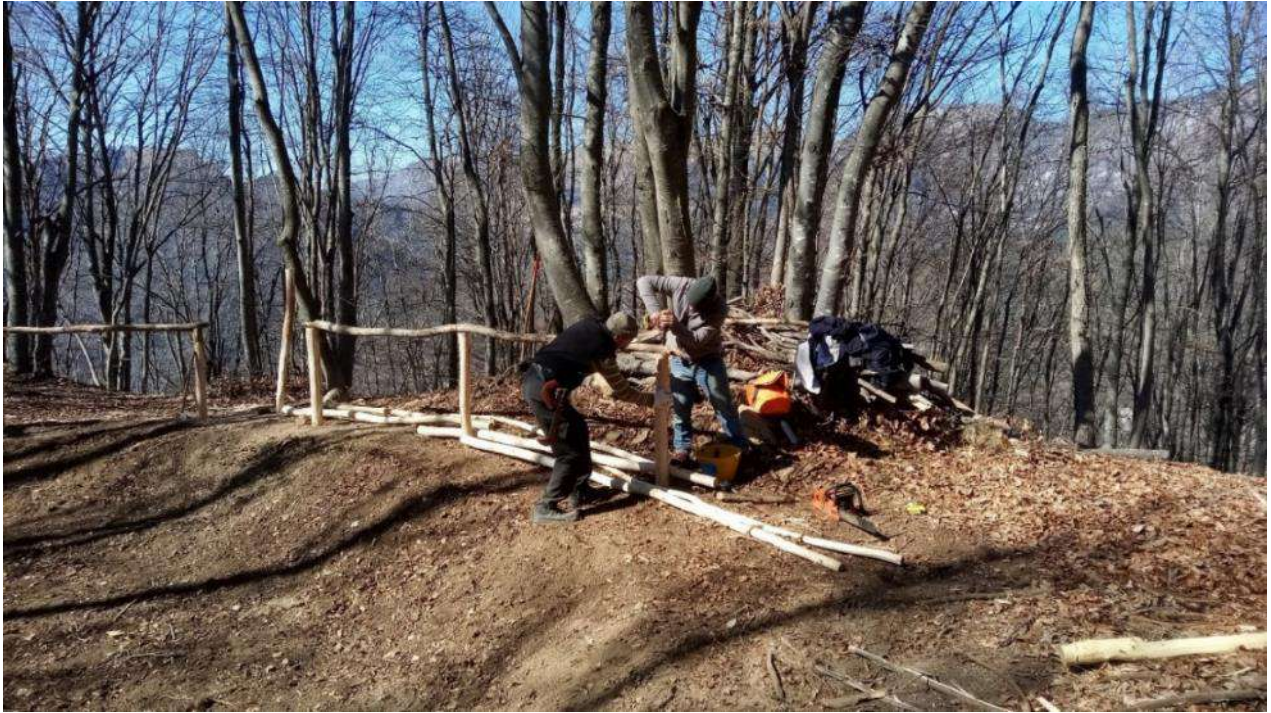
Realizzazione della staccionata perimetrale
