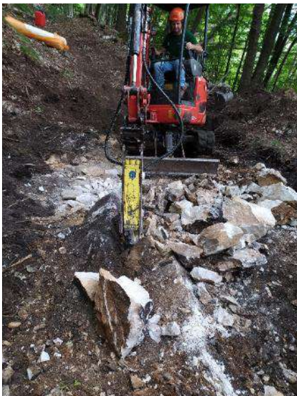
Spacco e conformazione roccia di fondo per realizzazione pozza, con finalità faunistica, in area carsica con scarsità di acque superficiali
