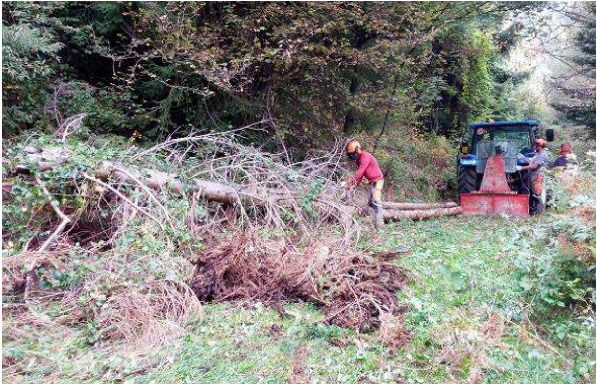
Foto 1 – Costa del Palio, habitat 9180. Fase di abbattimento delle conifere sulla strada ASP “della Piacca”
