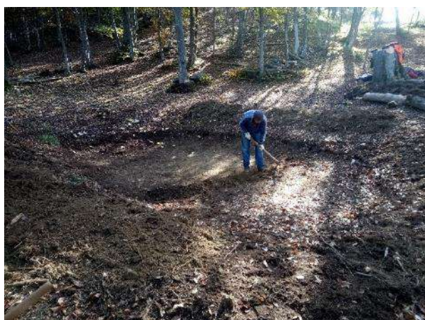
Fasi realizzative - trasporto dei materiali, scavo manuale, posa e naturalizzazione del fondo con posa di strato di terra.
