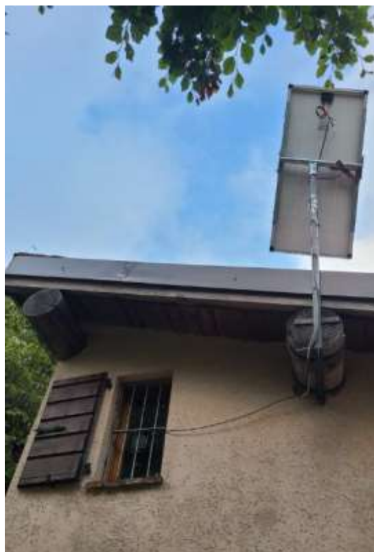
Figura 39 – Rilevatore di ultrasuoni posizionato dietro le grate della finestra, col microfono all'esterno dell'edificio.
