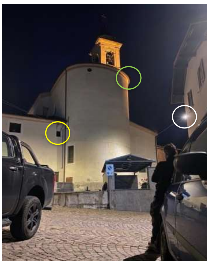
Figura 28 – Ingresso della colonia di Myotis emarginatus (in giallo). Si evidenzia la presenza di cavi elettrici utilizzabili da roditori o altri animali per l'ingresso al sito. È inoltre presente un lampione che illumina l'accesso al sito (cerchio bianco). In verde è evidenziata la posizione di un'altra apertura utilizzata dagli animali per l'accesso al sito, ampiamente illuminata.
