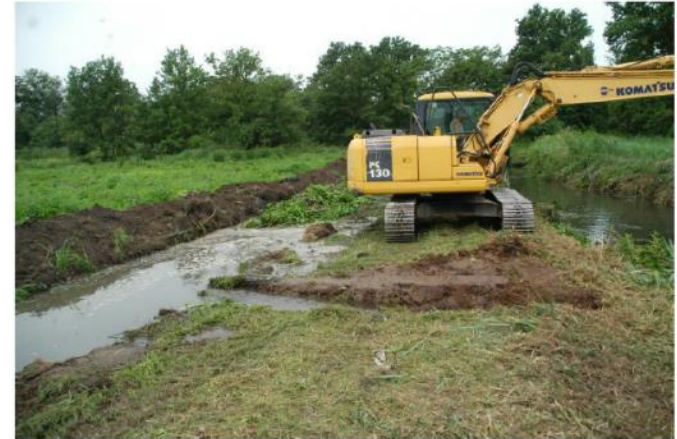
Figura 23. Realizzazione di canaletti temporanei di scolo dell'acqua dalla trincea di stoccaggio verso il canale (Foto Luca Gariboldi).
